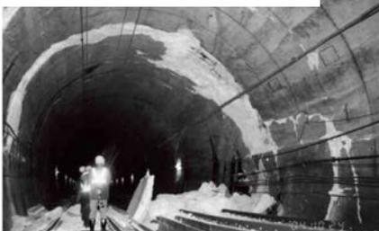
写真-3 地質不良区間での被害例 (魚沼トンネル)
