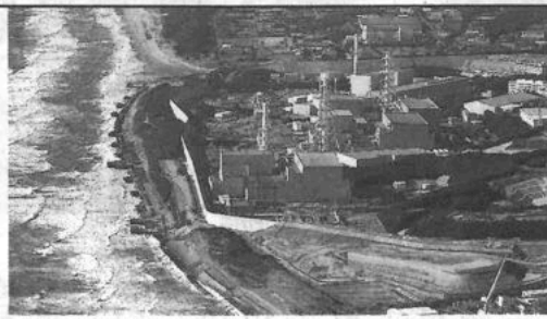
巨大地震に備え防波壁に囲まれた中部電力浜岡原発—2018年、静岡県御前崎市
