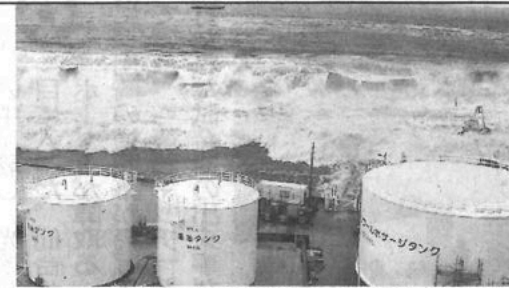
防波堤を破壊し、福島第一原発を襲う大津波。高さ10mの敷地が浸水した—東京電力提供
